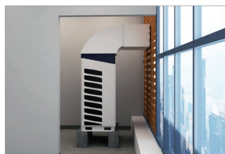
Instalace VZT potrubí
