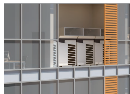
Ukryté venkovní jednotky uvnitř budovy
